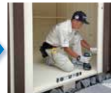
「フジ産業」と社名の入った工事部のスタッフが組立工事をしていただく事により、安心して長くお使いいただけます。
